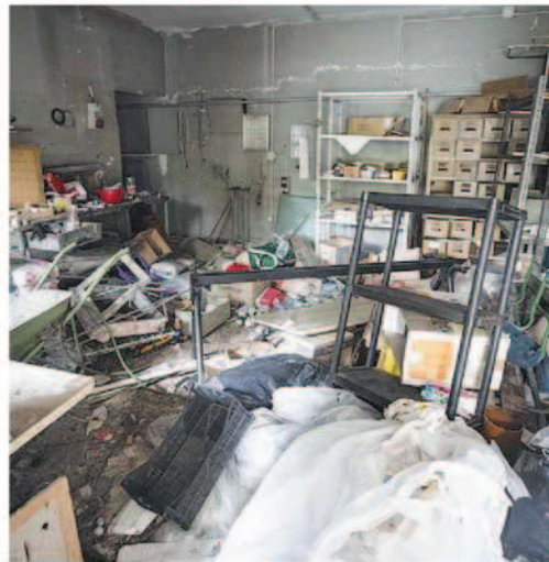
Degrado Alcune immagini dell'interno e dell'esterno della struttura lasciata allo sbando
